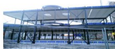
Staalconstructie en Vloerkanalplaten gereed
